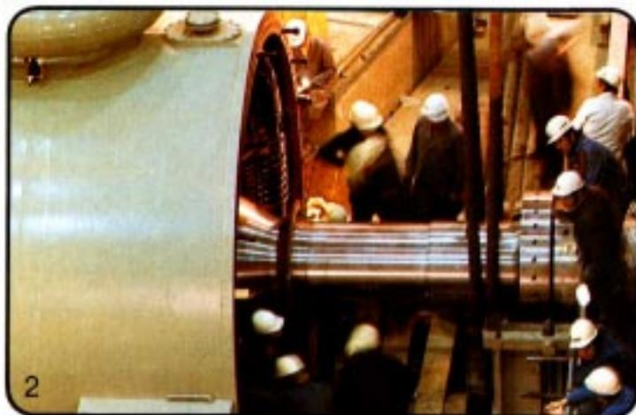
Die Welle zwischen Turbine und Generator eines Kraftwerks wird montiert.
